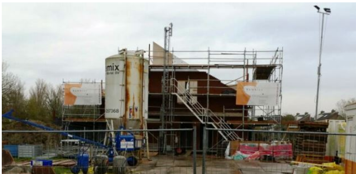
De B&B in aanbouw.
